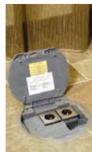
Традиционному размещению розеток на стене хозяева предпочли не совсем привычный вариант их устройства в полу. Такое решение оптимально для больших помещений. Группа розеток в гостиной расположена под креслом и закрыта щитком
